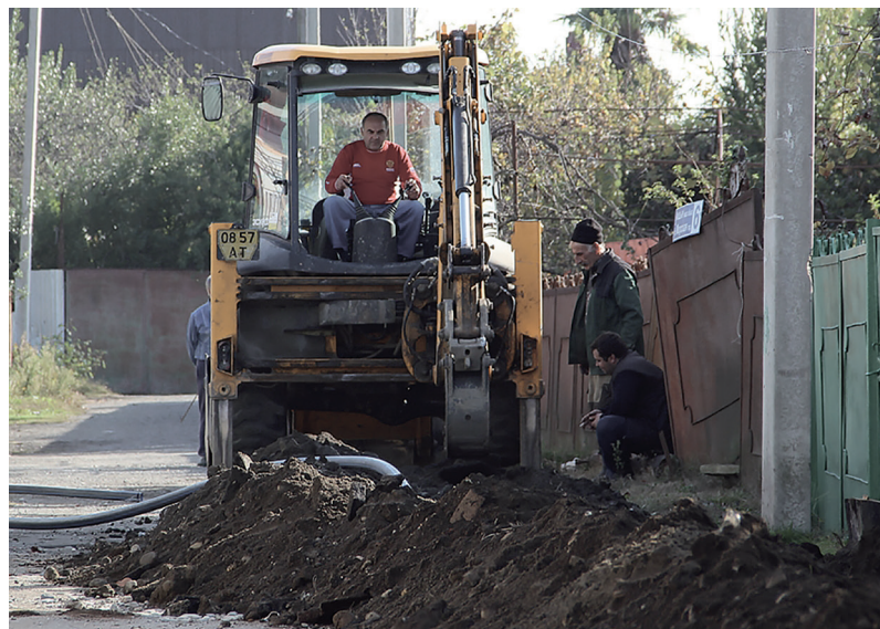
Служба Коммунального управления МУП РСУ проводит работы по прокладке нового водопровода на улице Красномаякская.
